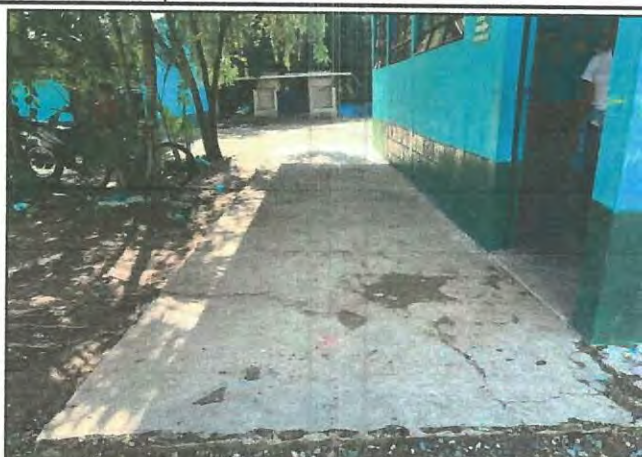
Foto 2: Mejoramiento de piso tipo torta a piso cerámico en corredor de aulas.
